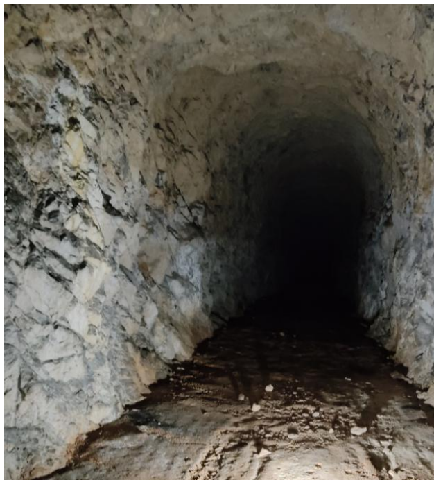
Imatge 23: Excavació sense revestir. Foto de l'autor.
