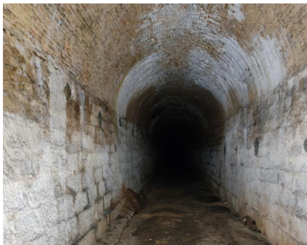
Imatge 24: Zona amb el revestiment de parets i sostre. Foto de l'autor.
