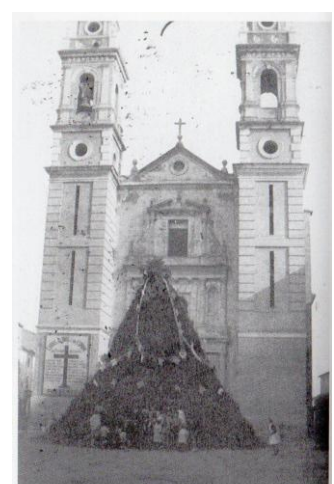
Els dos templets estan fets però el rellotge encara no està instal·lat. Fotografia de 1961
