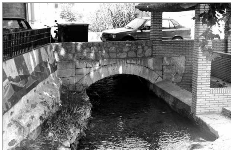
PONT SOBRE EL RIU DELS SANTS A L'EIXIDA DEL GOLERÓ
