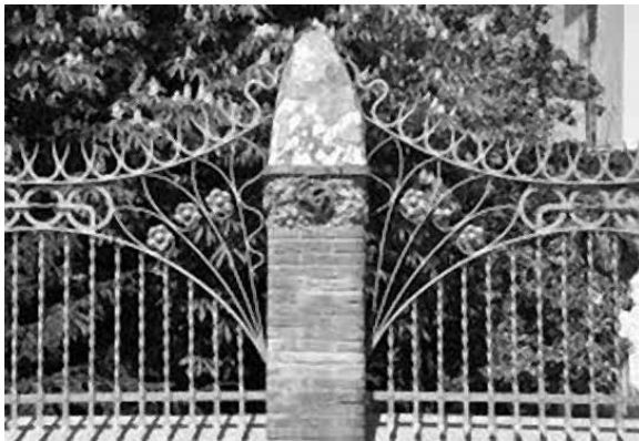
DETALLE DE LA VALLA DE LA CASA BAUMANN.
