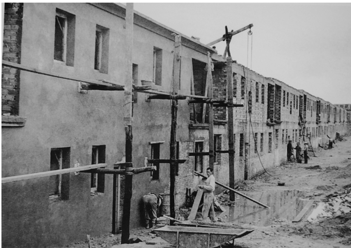
CONSTRUCCIÓ DEL GRUP DEL CARRER DE SANT JOAN DE RIBERA.
