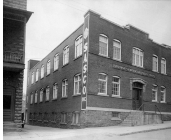
11 CAYADUTTA STREET, GLOVERSVILLE (NY), USA.
