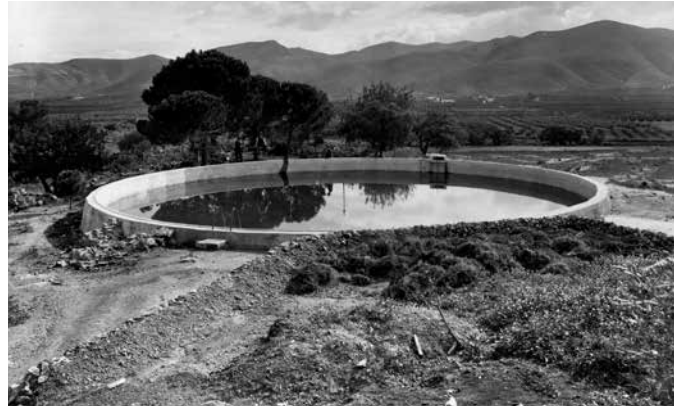
CONSTRUCCIÓN DE LA Balsa PRINCIPAL AÑO 1930
