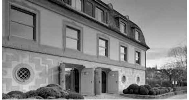
LA CASA "ZEPPELIN" VISTA LATERAL.
