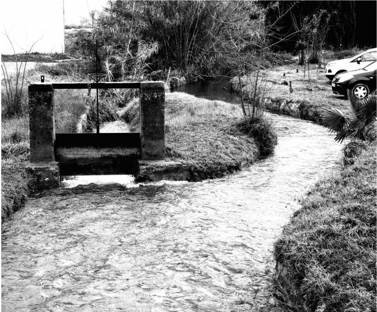
IMATGE ACTUAL DEL SOBREEIXIDOR (22-1-2020).
