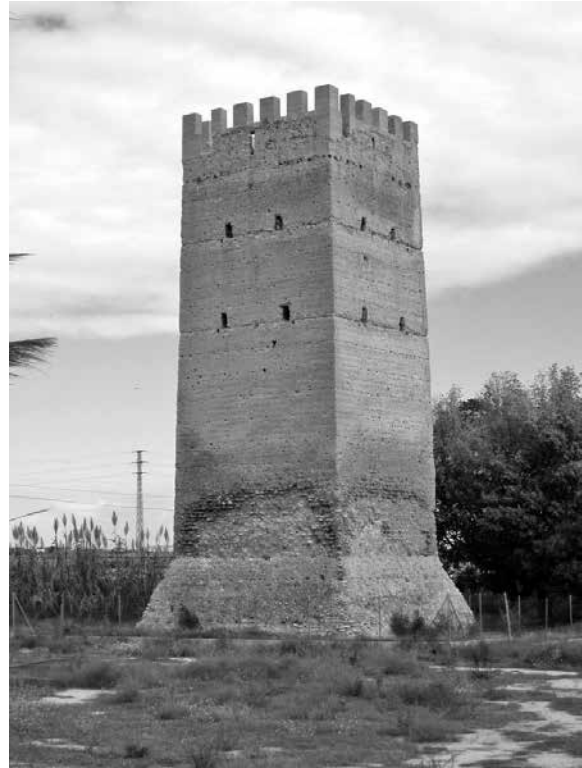
TORRE DE MUZA DE BENIFAIÓ ABANS I DESPRÉS DE LA SEUA RESTAURACIÓ AL 2014.
