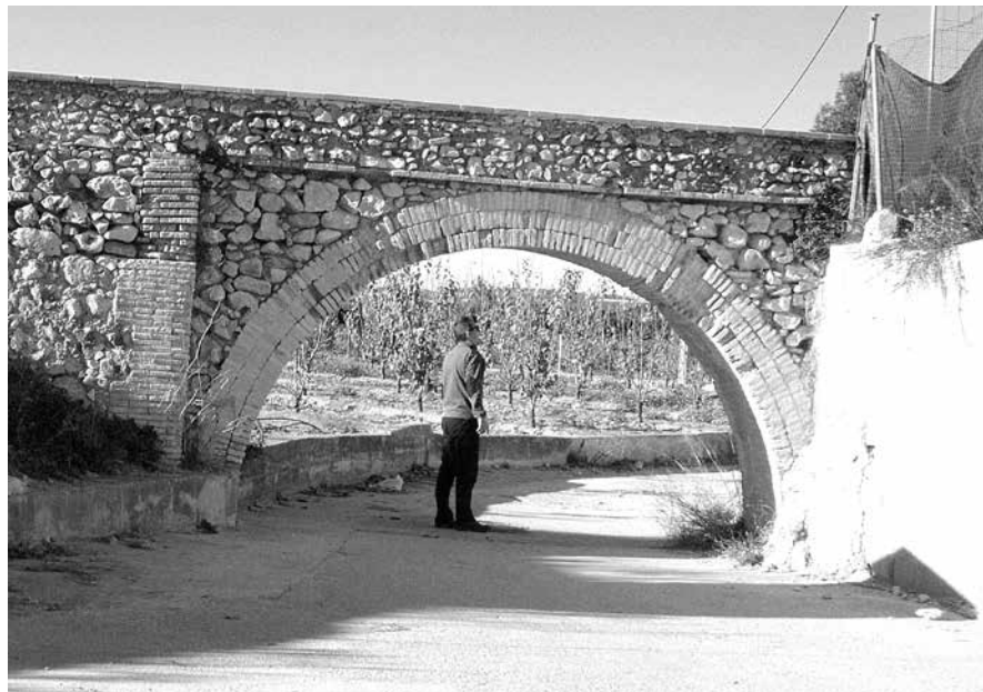
ARCADETA DEL PLA NOU QUE CANALITZA LES AIGÜES DEL MATEIX PLA
