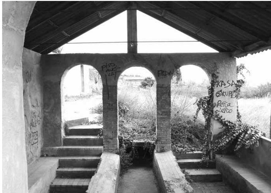
SAFAREIG DE LA TORRE DELS FRARES EN ESTAT D’ABANDONAMENT.
