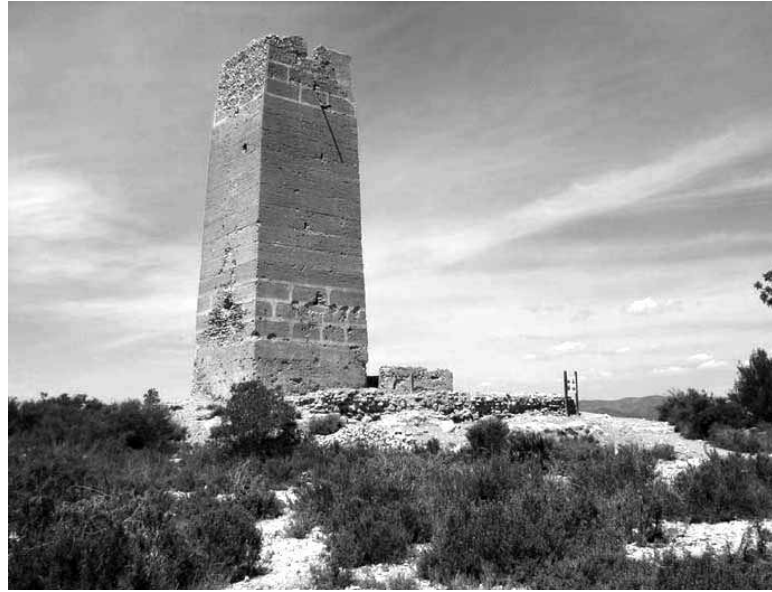
TORRE BOFILLA A BÉTERA AMB LA TÈCNICA DEL “FALSO DESPIECE DE SILLERÍA”.
