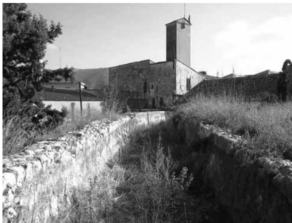
(8) DETALL DEL CANAL. FOTOGRAFIA DE L'AUTOR.
