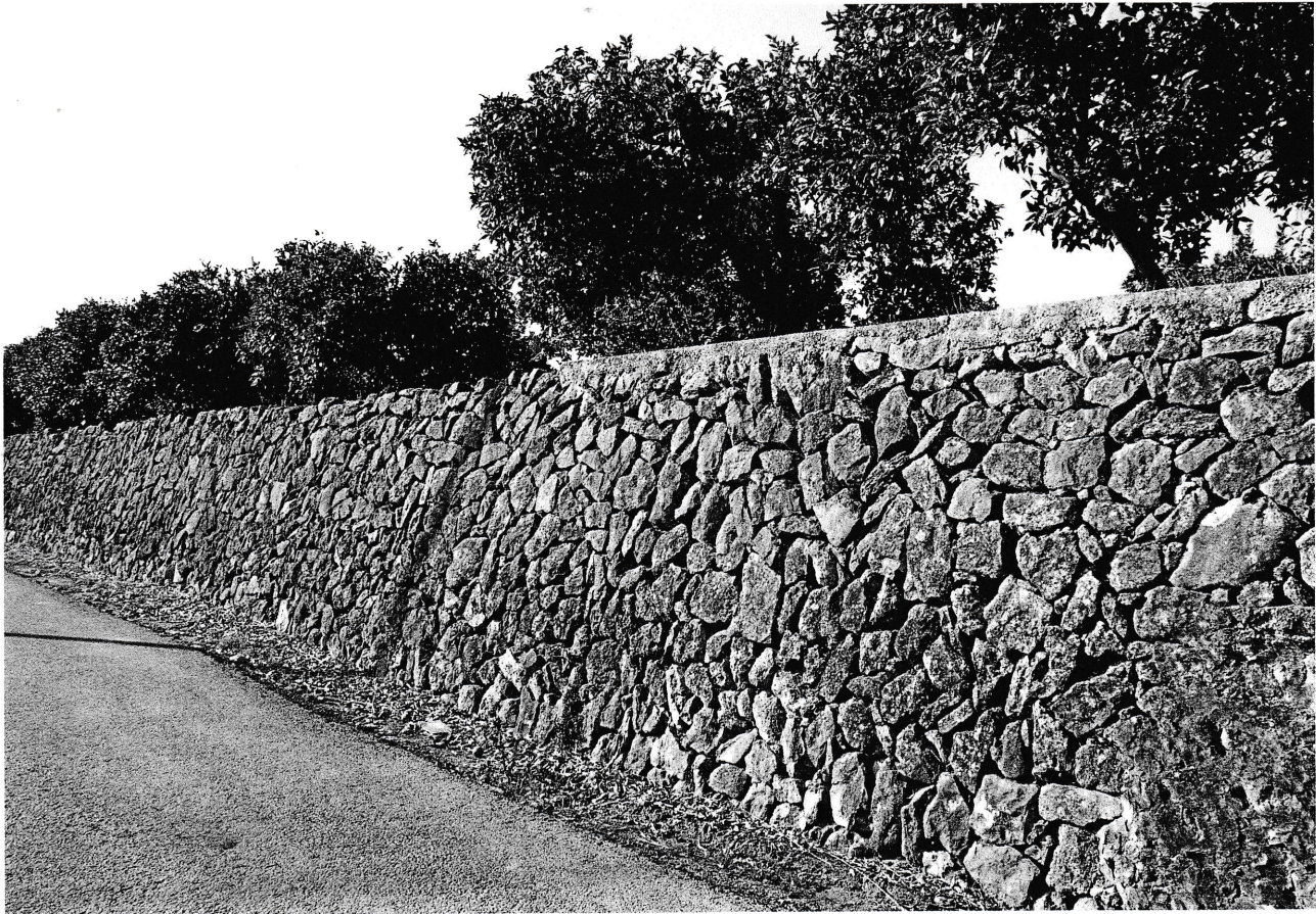
17. Calçada de marge a l'Estepar, amb pedra treballada i col·locació perfecta. (Canals. L'Estepar).
