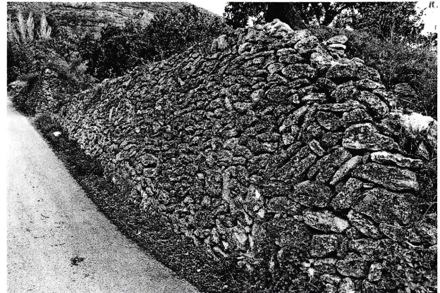
8. Calçada de marge amb lloses. Canals, els Cinc Germans.
