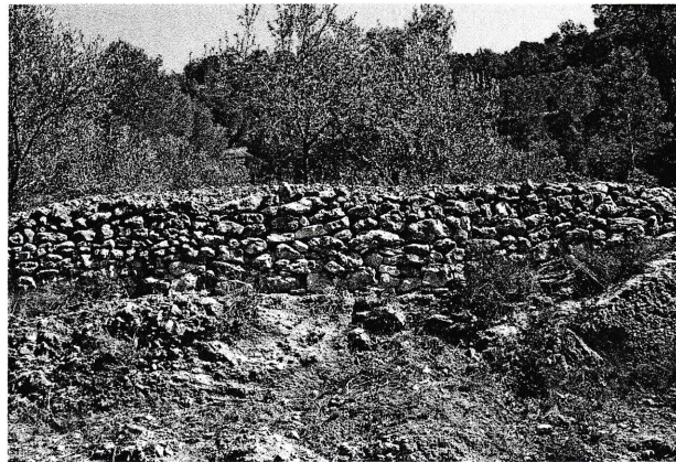
10. Calçada de marge amb pedres irregulars. Canals, el Port.
