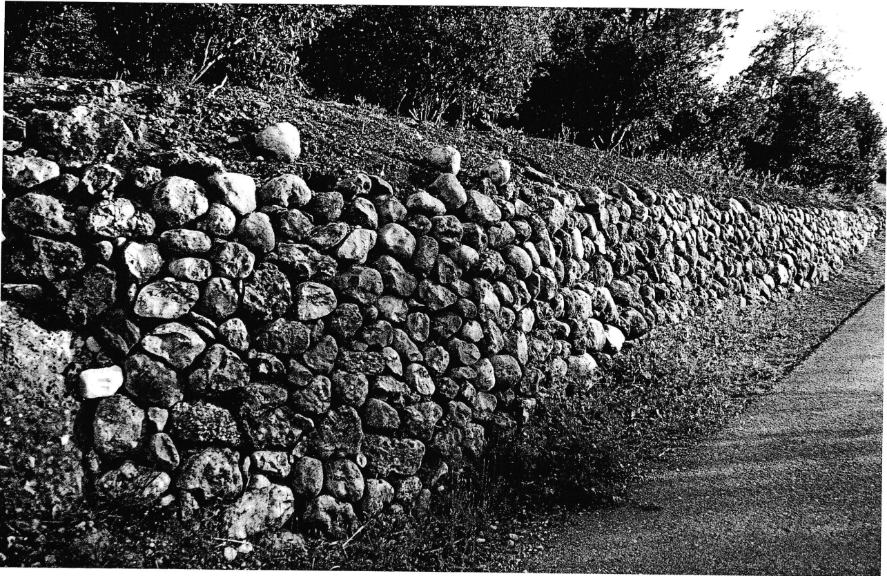
3. Calçada de marge, amb còdols del Riu Canyoles. Canals, les Moles.
