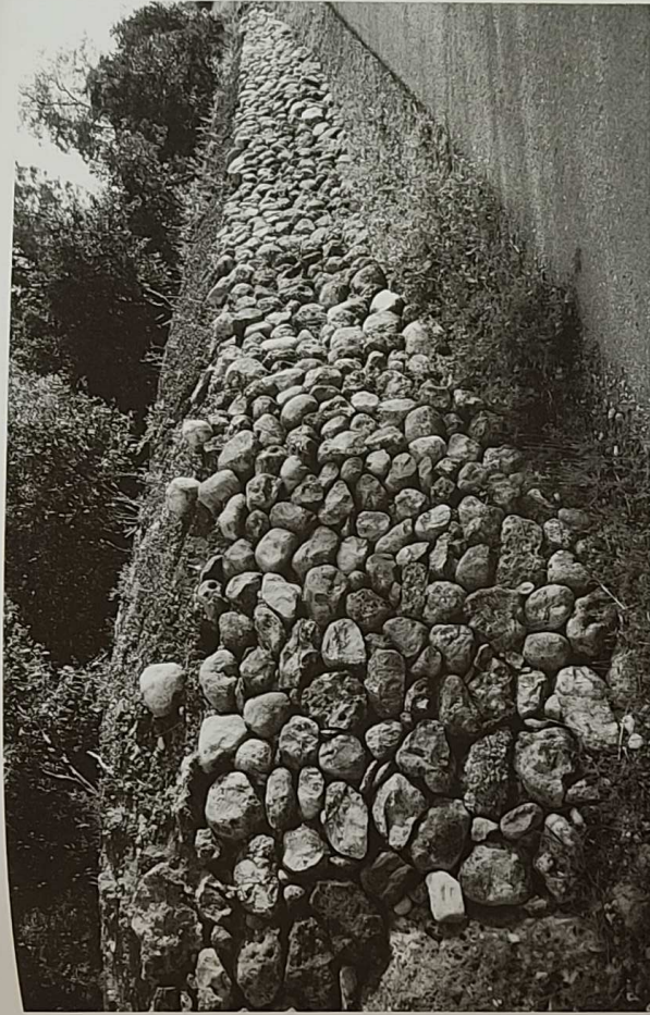
3. Calçada de marge, amb còdols del Riu Canyoles. Canals, les Moles.
