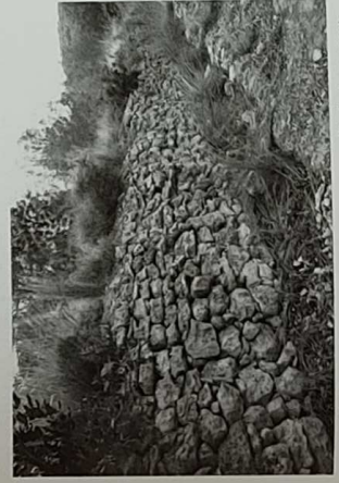
7. Calçada de marge amb pedres irregulars a l'indret conegut com el Racó de Mariquita.
